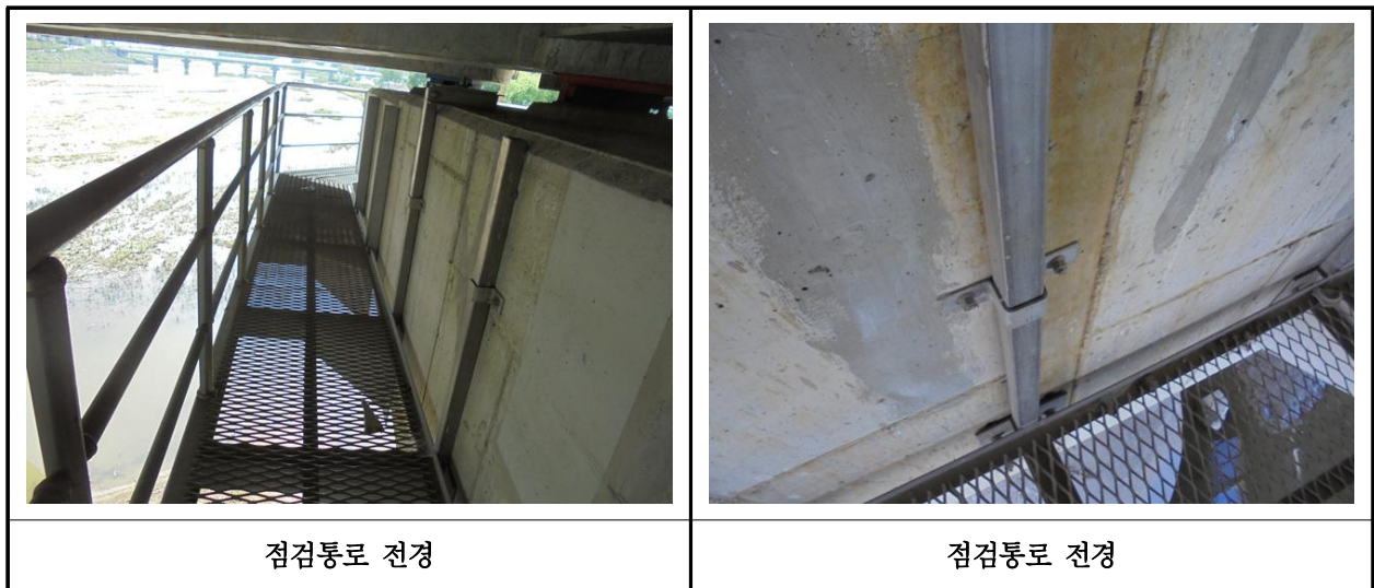
【사진 1.3.27】 교량 점검시설 전경
