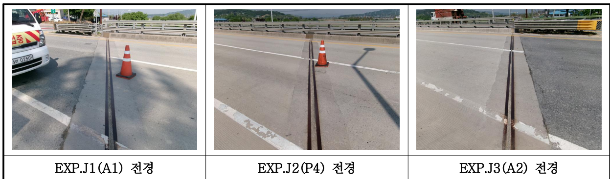
【사진 1.3.18】 신축이음장치 전경
