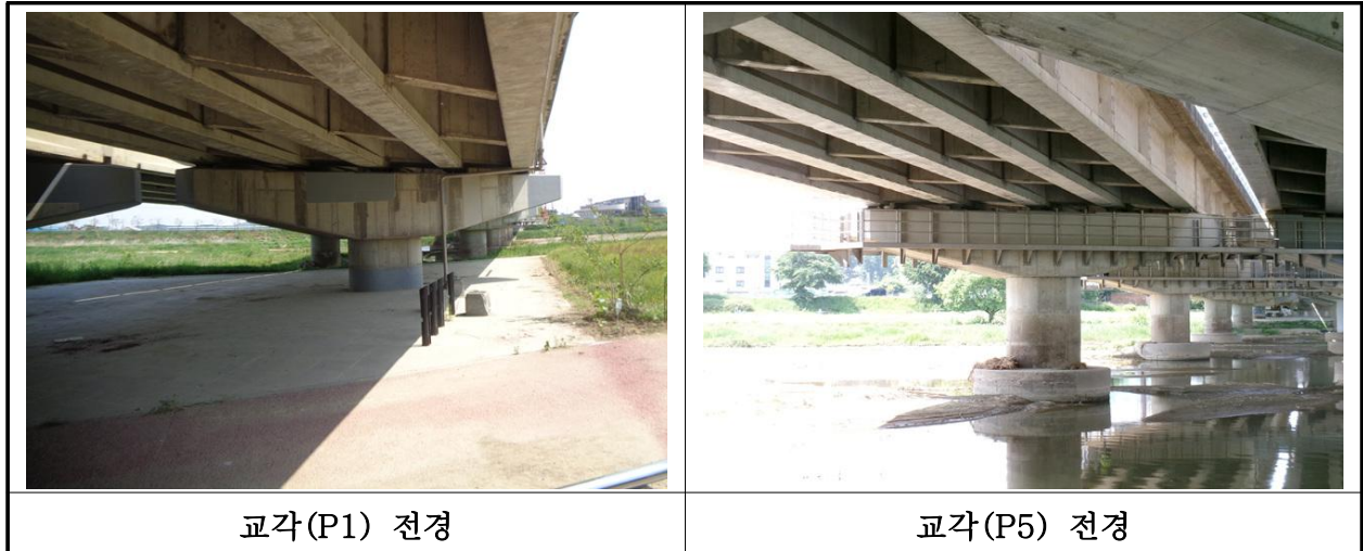
【사진 1.3.10】 교각 전경
