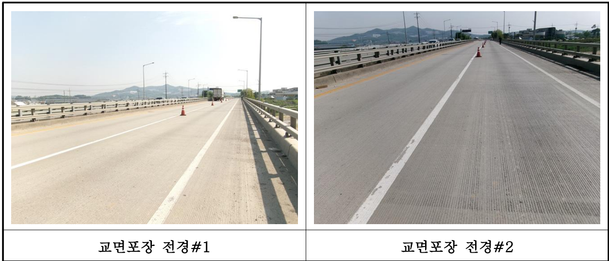
【사진 1.3.21】 교면포장 전경
