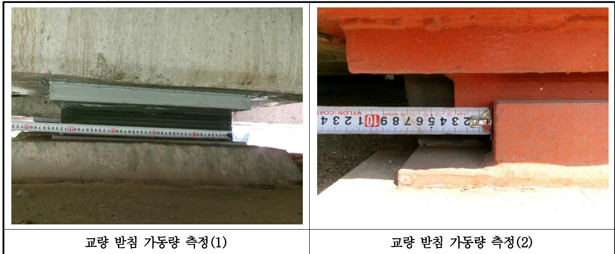
【사진 1.3.17】 교량받침 이동량 측정
