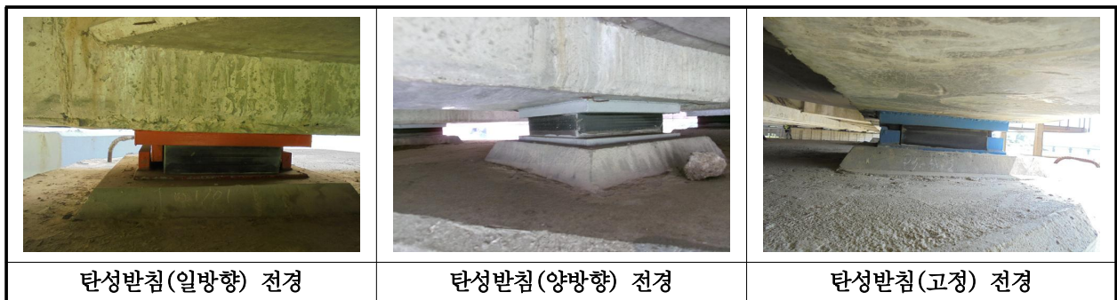
【사진 1.3.14】 교량받침 전경
