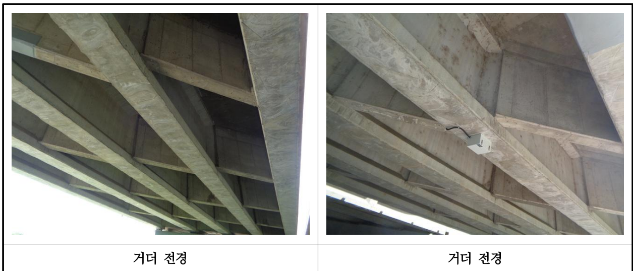
【사진 1.3.4】 거더 전경
