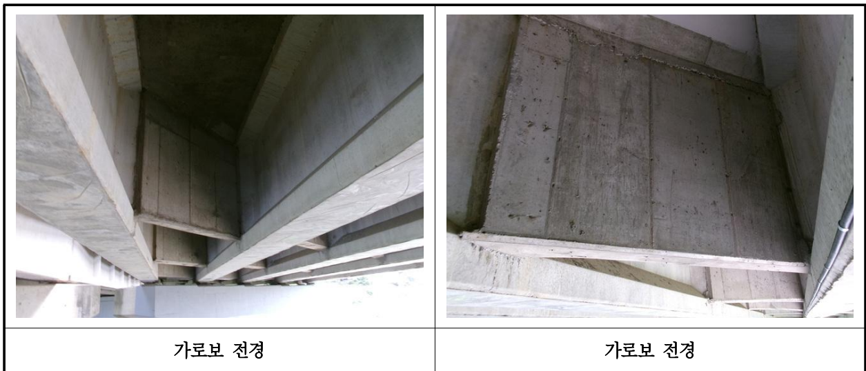
【사진 1.3.6】 가로보 전경
