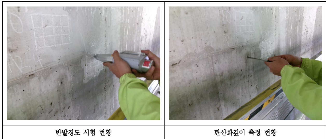
【사진 1.4.1】 콘크리트 내구성조사 현황
