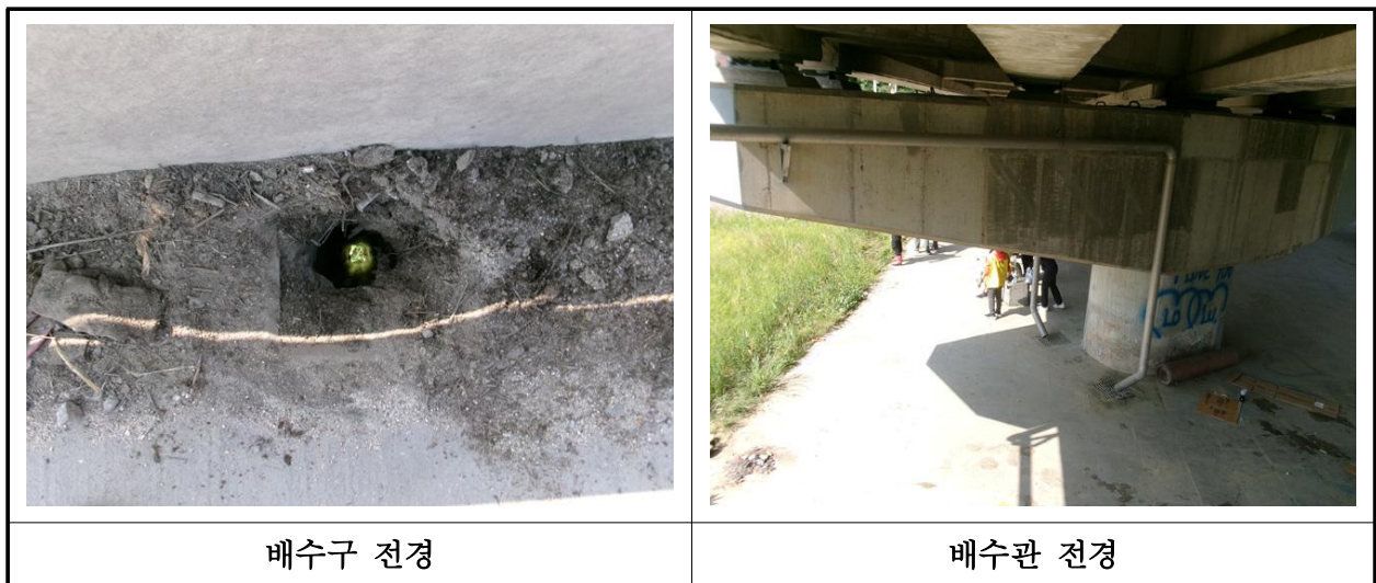
【사진 1.3.23】 배수시설 전경
