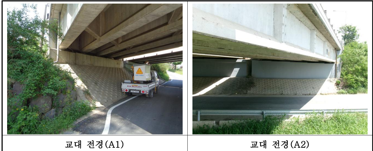
【사진 1.3.8】 교대 전경
